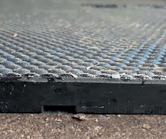
Seitenansicht mit Lüftungskanal
