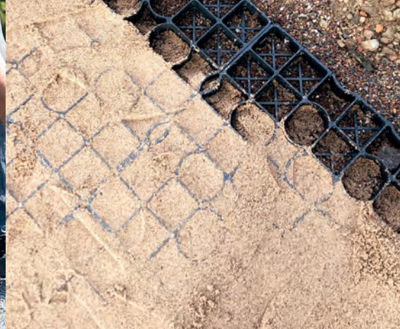
ProGrid mit Sand verfüllt
