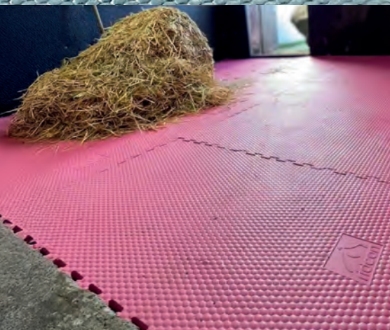
Pinke EVA Matten verlegt
