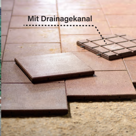
Verlegung im Versatz
