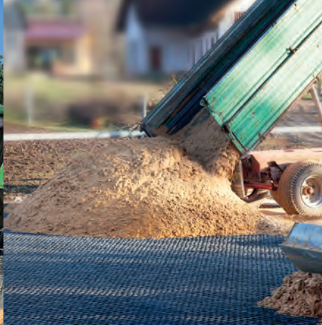
Anlieferung des Füllmaterials
