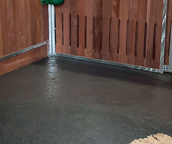
Flüssiggummi auf Betonboden
