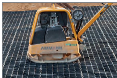
Empfohlene Rüttelplatte Gewicht: > 250 kg
