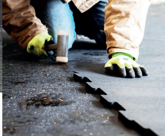
Verlegen der Matten
