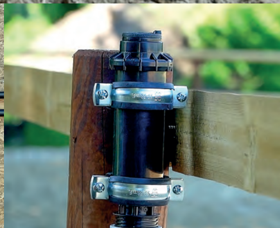
Regnerkopf am Pfosten installiert
