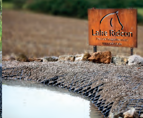
Befestigung eines Teiches
