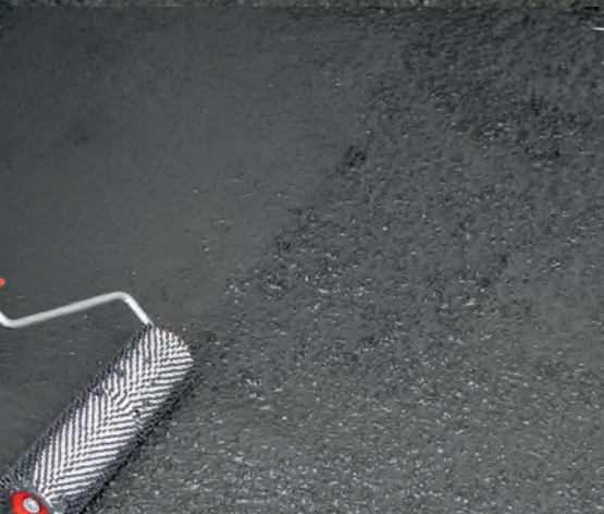
Entlüften mit der Nadelrolle
