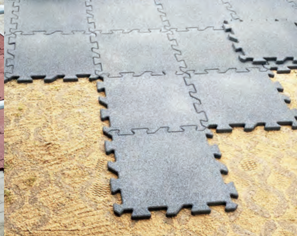
Verlegung auf Rasengittersteinen
