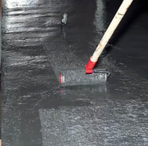
Glätten und Luftblasen entfernen
