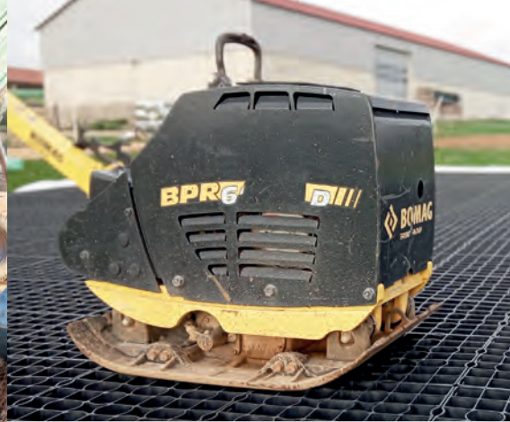
Abrütteln vor der Verfüllung
