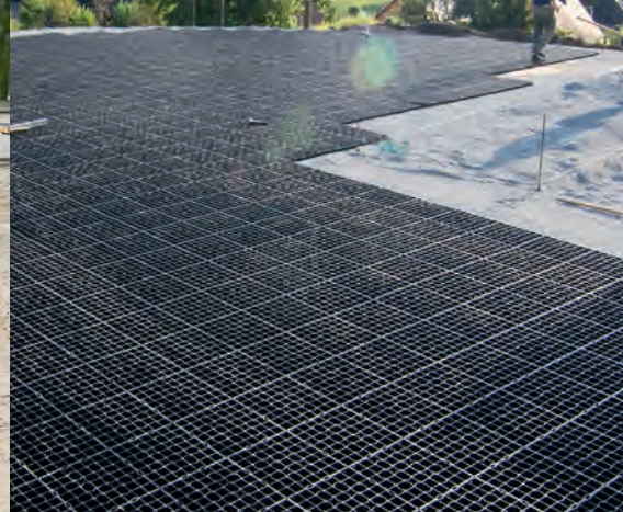
Großer Auslauf im Kreis verlegt
