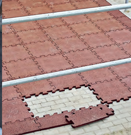
Sauber verlegt auf Pflaster
