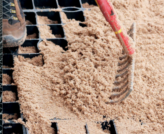
Verfüllen der Gitter
