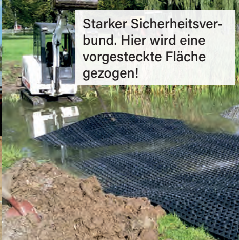
Befestigung einer Wasserdurchfahrt
