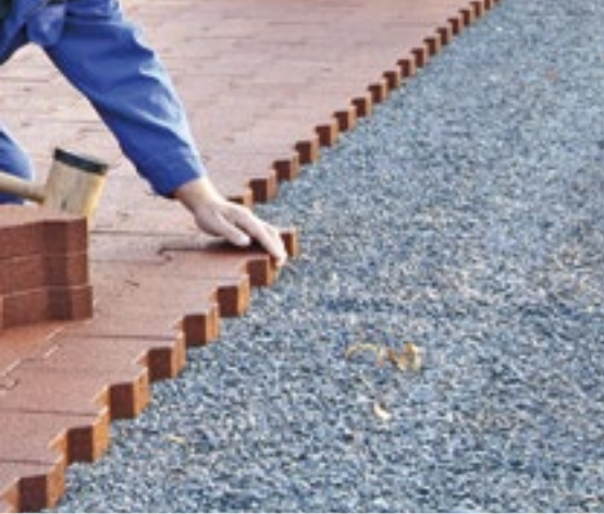
Verlegung auf Splittbett
